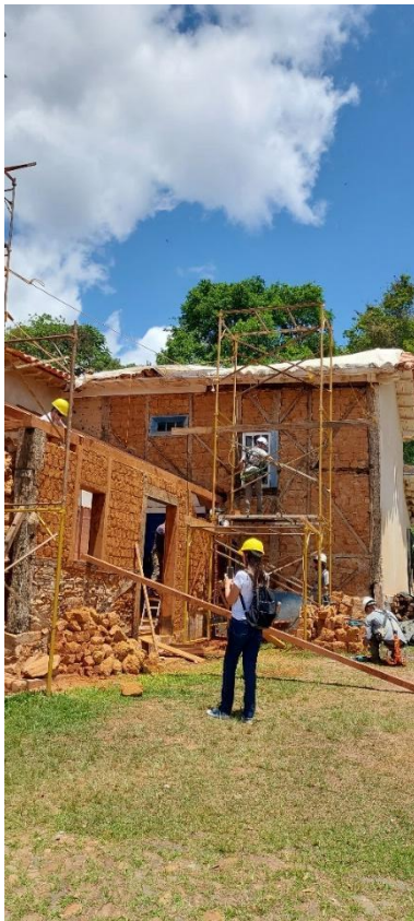
Alvenarias externas de adobe Autoria: Maria Letícia Ticle Data: 16/10/2023
